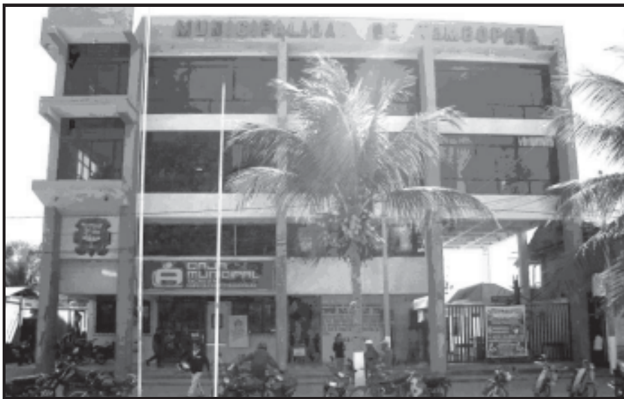
Frontis de la Municipalidad Provincial de Tambopata Cortesía: INEI - Oficina Departamental de Madre de Dios
