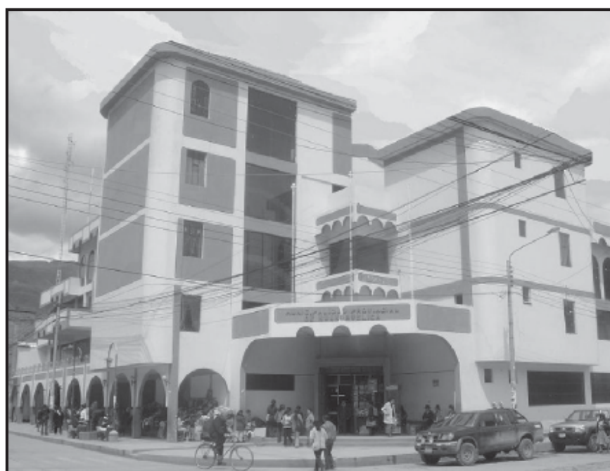
Frontis de la Municipalidad Provincial de Huancavelica Cortesía: INEI - Oficina Departamental de Huancavelica
